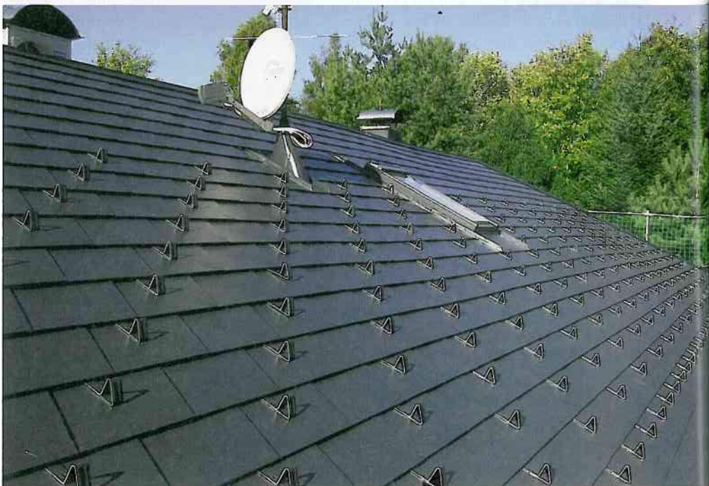
▼ Die Möglichkeiten sind vielfältig: Bei den Dachschindeln wurde ein Schneestopper-System im engen Raster eingebaut ...
