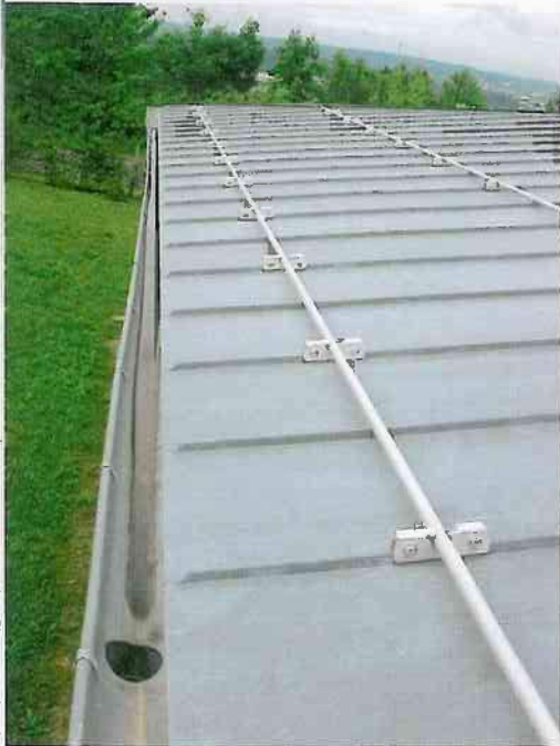
Hier wurde ein Schneefangrohr auf jeden zweiten Falz aufgeklemt, ...
