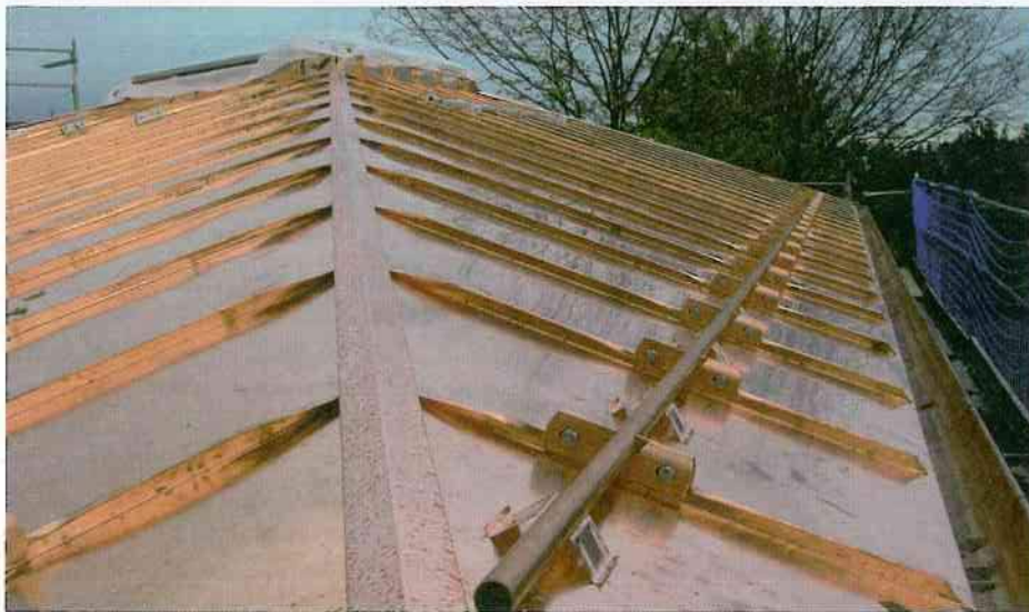
◀ Hier dürfte nichts mehr passieren: Das Schneefangrohr wurde auf jedem Falz aufgeklemt und zusätzliche Eisspalter in der Schar verhindern, dass die Rinne verformt wird und dass Schneebretter oder Eisplatten vom Dach rutschen.
