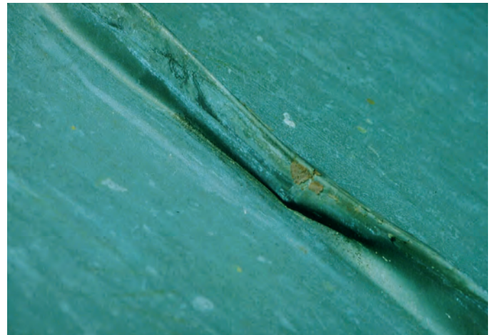
So sehen Stählfalze nach einem schneereichen Winter aus, wenn die Anzahl der Schneefanghalter nicht ausreicht.
